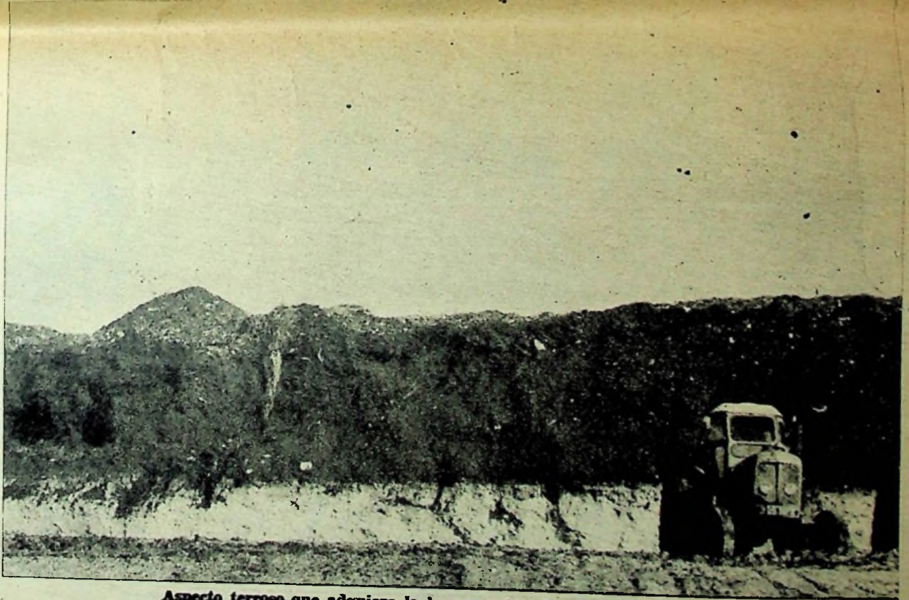
Aspecto terrroso que adquiere la basura a los cinco años de haber sido vertida y compactada. Vertedero de WOETHING (Surrey)
