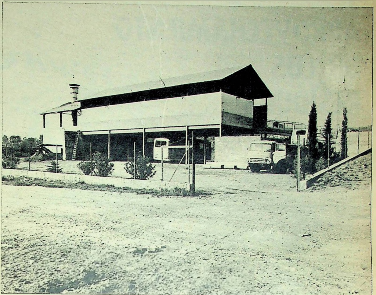
Vista de la instalación Incineradora, con almacén de basuras en su parte alta. A la izquierda se ve la salida automática del residuo. También la chimenea, "sin humo", en pleno funcionamiento
