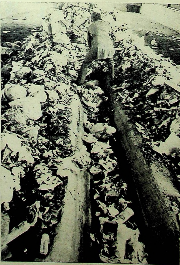
carga del horno mediante cinta transportadora
