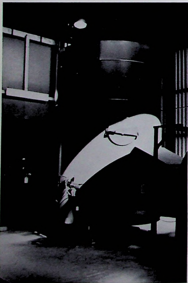
Multicyklonfilter i forbindelse med oliefyret kedel
